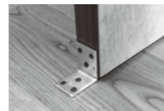
L型金具による床固定
